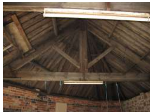
fig 26) king post truss
