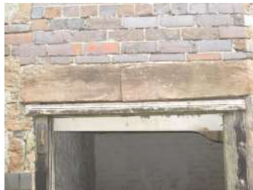
fig 24) cracked lintel
